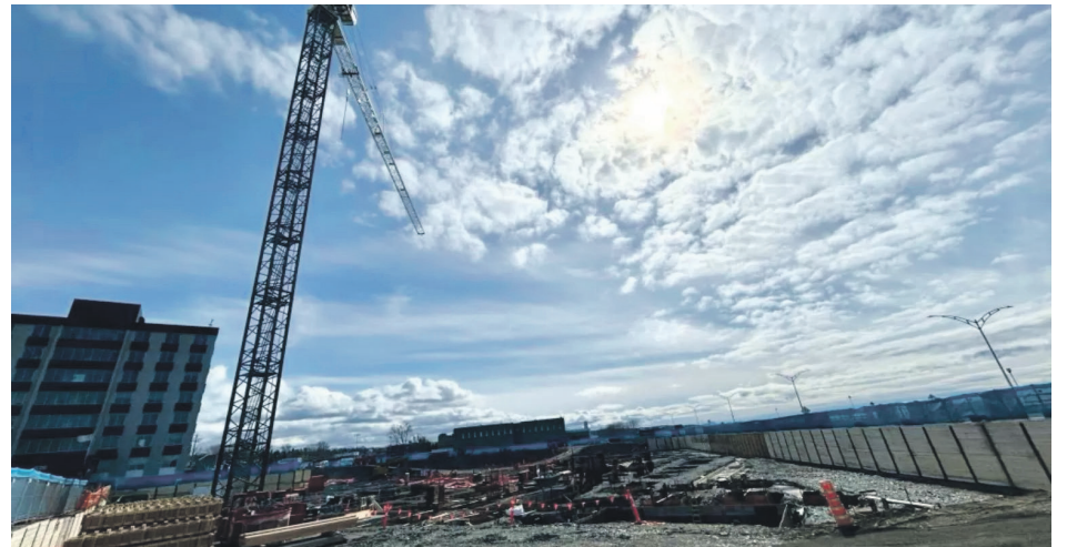
Le chantier du « Quartier Maritime » de la Société Angus au centre-ville de Rimouski. Photo Olivier Therriault
