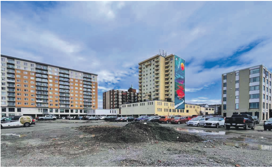
Le trou béant laissé par la démolition de La Grande Place. Photo Johanne Fournier
