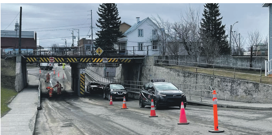
Un précédent chantier sur le boulevard Jacques-Cartier. Photo Olivier Therriault
