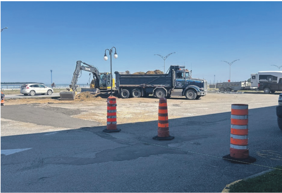
La construction de l'annexe est entamée à proximité de l'Hôtel Rimouski. Photo courtoisie
