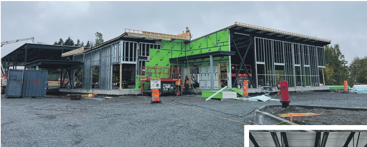
La nouvelle caserne située sur la montée Sainte-Odile. Photo Annie Levasseur
