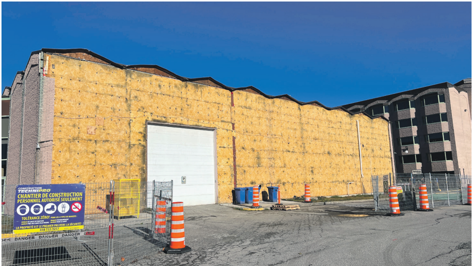
Les travaux préparatoires sont terminés à l'Hôtel Rimouski. Photo Annie Levasseur
