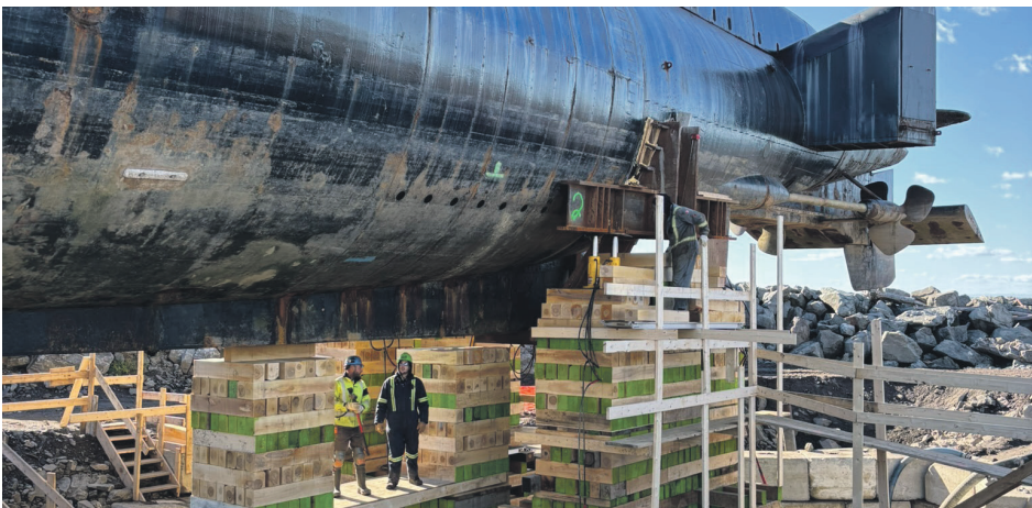
Les travaux de levage de l'Onondaga ont été réalisés dans les dernières semaines au Site historique maritime de la Pointe-au-Père. Photo courtoisie
