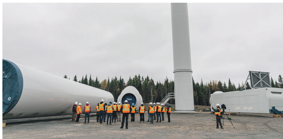
Des éoliennes du parc PPAW en cours de construction. Photo CRT Construction
