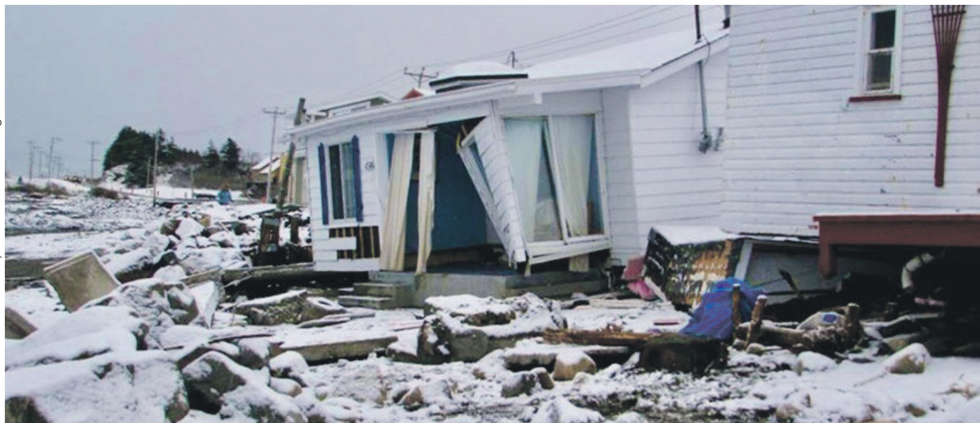
Au total, 72 résidences ont dû être démolies après les grandes marées de 2010. Photo courtoisie
