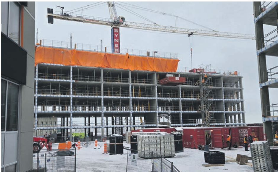
Le chantier du Quartier Maritimes à Rimouski avance bien. Les échéanciers sont respectés. Photo Alexandre D'Astous
